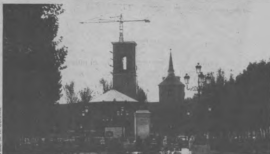
SE ESTAN REALIZANDO las obras de reconstrucción de la torre de Santa María y de la capilla del Oidor, como se puede apreciar en la fotografía.
