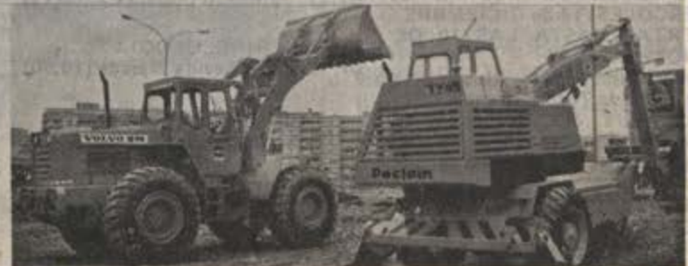
EXCAVACIONES Y MOVIMIENTO DE TIERRAS
