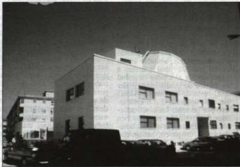
Vista general de la iglesia. Fachada lateral.
