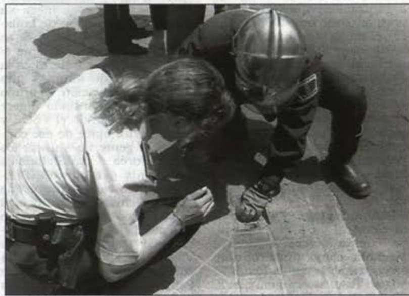
Las bocas de riego no se encontraban en buenas condiciones.
