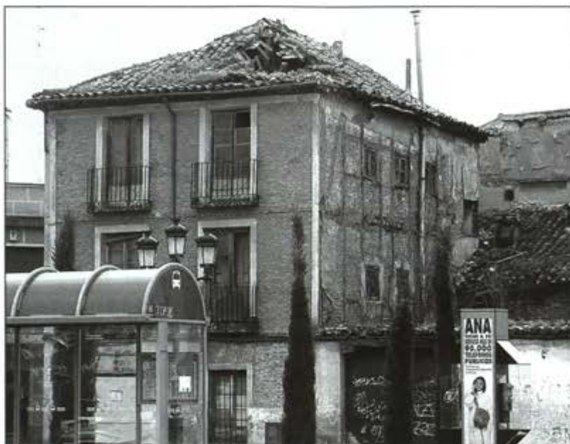
El estado de esta casa, frente al antiguo Hospital de San Lucas, no concuerda con una ciudad que es Patrimonio de la Humanidad.
