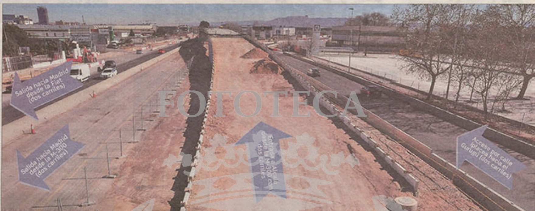
La construcción del nuevo acceso a Alcalá desde la M-300, que finalizará en junio, reducirá en cuatro minutos diarios los atascos
