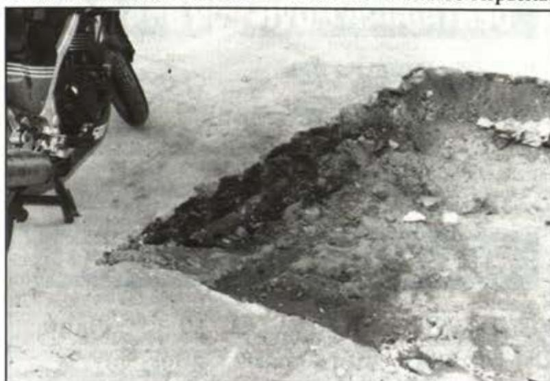
En la foto de la izquierda se puede observar como el álamo negro del fondo se ha inclinado con las obras; las raíces del chopo de gran tamaño (el tronco de la derecha) podrían haber roto la tubería de agua. A la derecha, una zona del pavimento hundida con las obras.
