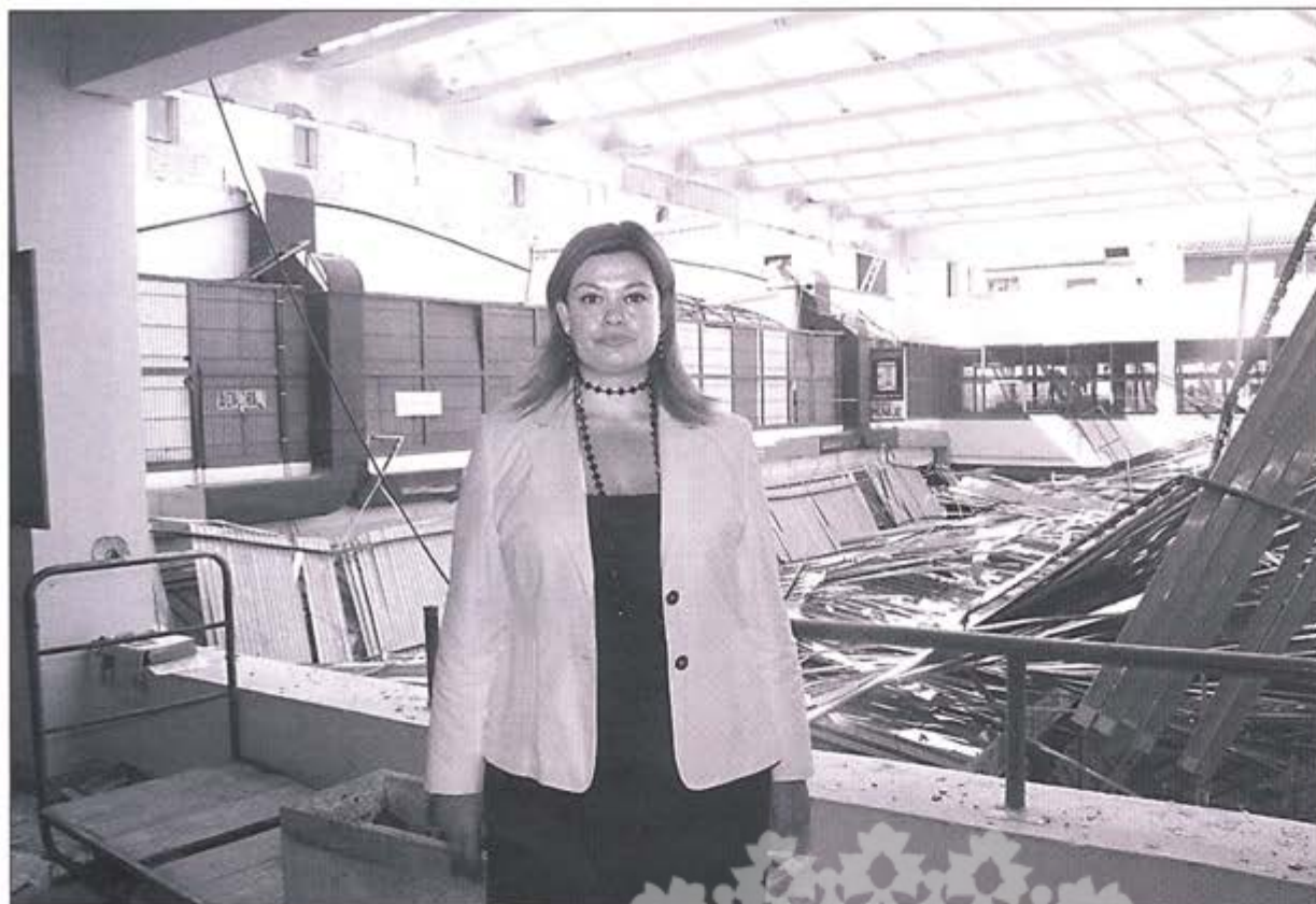
La concejala Marta Viñuelas en el interior del mercado en proceso de derribo.
