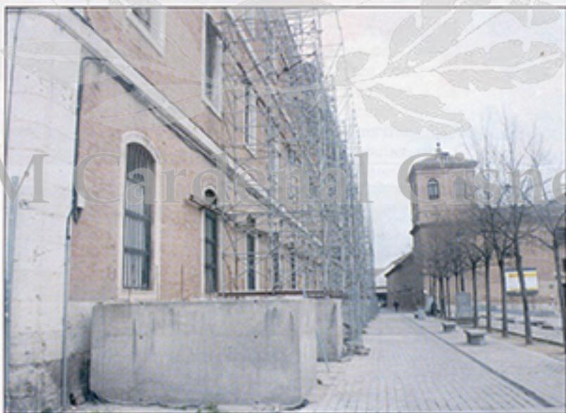
Base de hormigón ya limpia de andamiaje y otras que todavía sujetan las estructuras metálicas a la espera de ser desmontadas para su inmediata demolición
