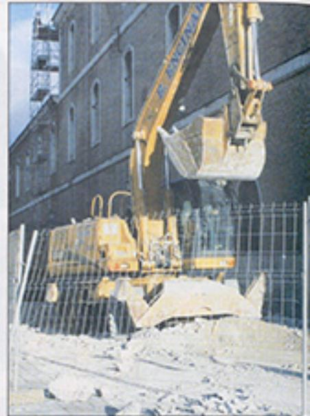
Una máquina excavadora trabajando para retirar el escombros producido por la demolición de los bloques de hormigón
