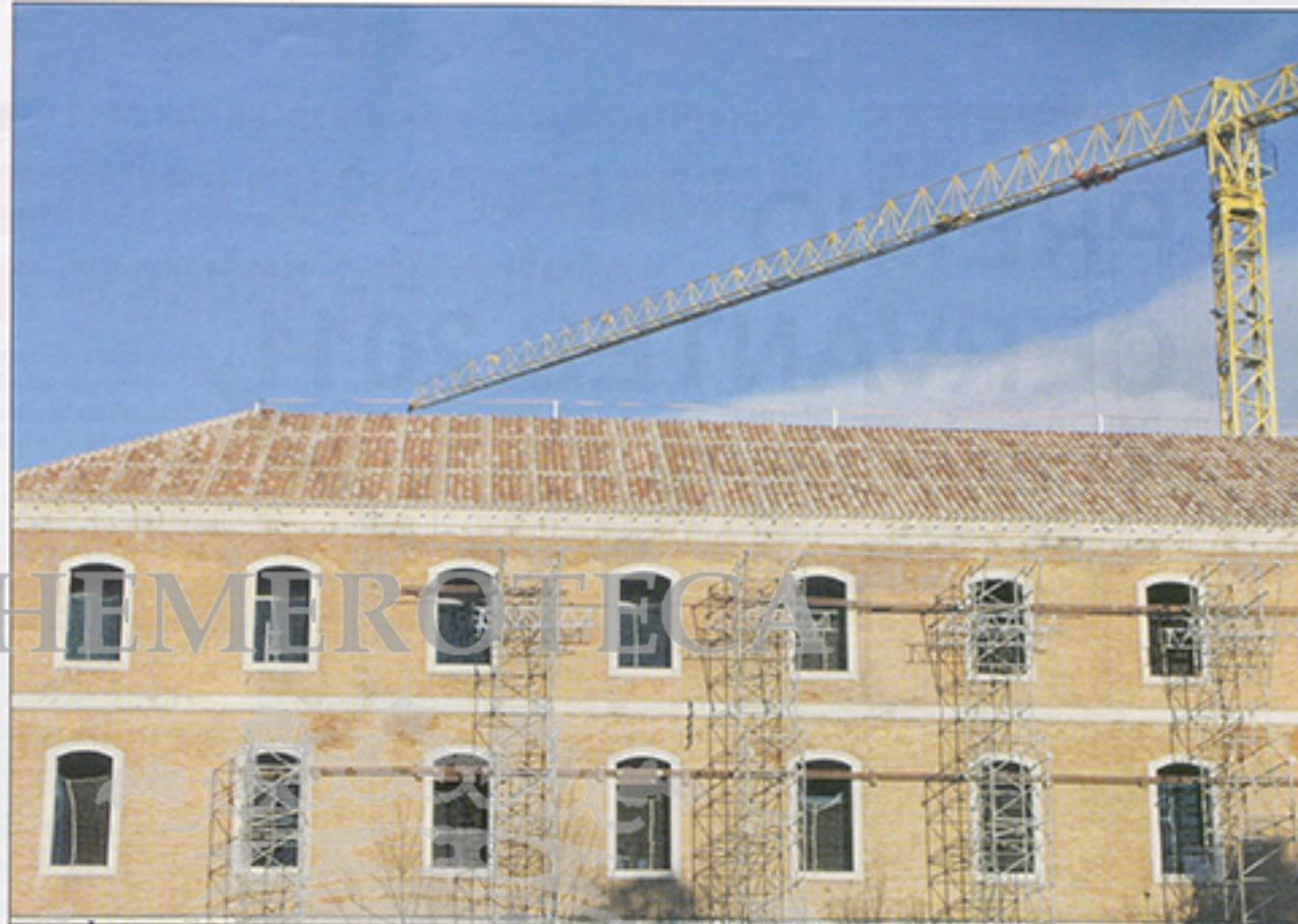
Fachada principal de los cuarteles donde se puede apreciar la finalización del tejado, bajo él se encuentra la estructura de madera más grande de España de 200 metros de largo por 18 de ancho
