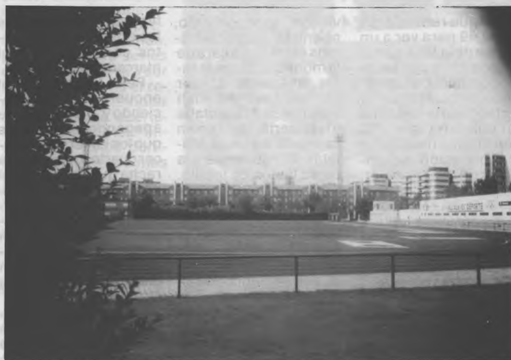
Como se puede apreciar el renovado recinto deportivo presenta un aspecto inmejorable
