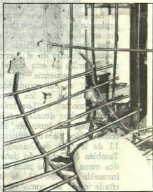
Ventana y rejas del primer patio
