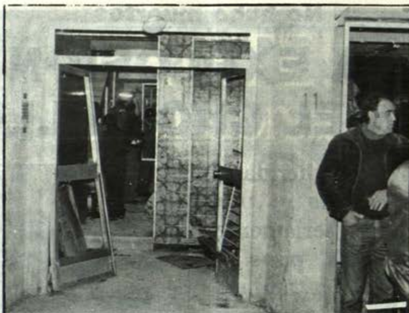
Portal de la casa afectada por el siniestro
