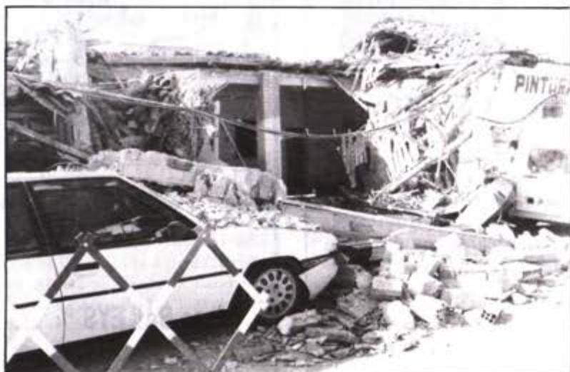
estructura antigua de casa vieja cayéndose parte del tejado, que era de tejas y cañizo. El hundimiento afectó a un Renault 4 F-6
