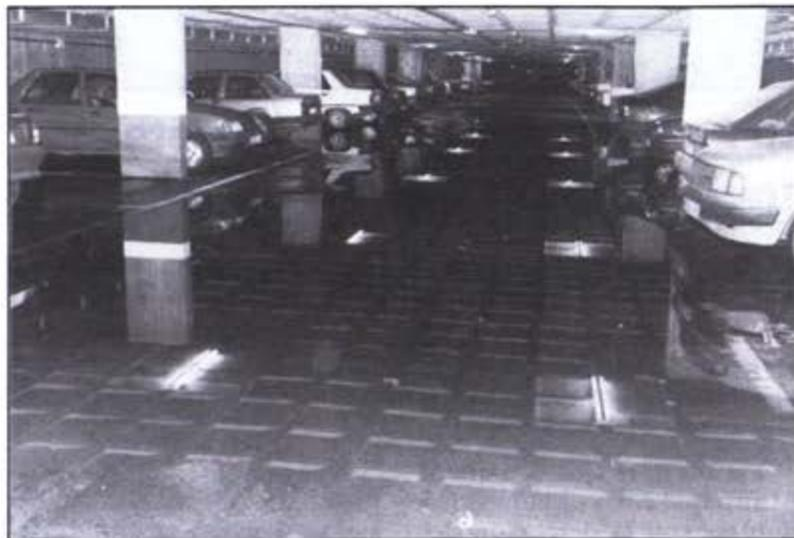
Las goteras (izquierda) son bien visibles, ya que las filtraciones no sólo se producen por las paredes y diversas entradas, sino también por el techo; a la derecha, como si de una piscina se tratara, el estado en que encontramos el aparcamiento cuando llegamos a hacer las fotos. Según el guarda, esto no es nada comparado con el agua que había dos horas antes.
