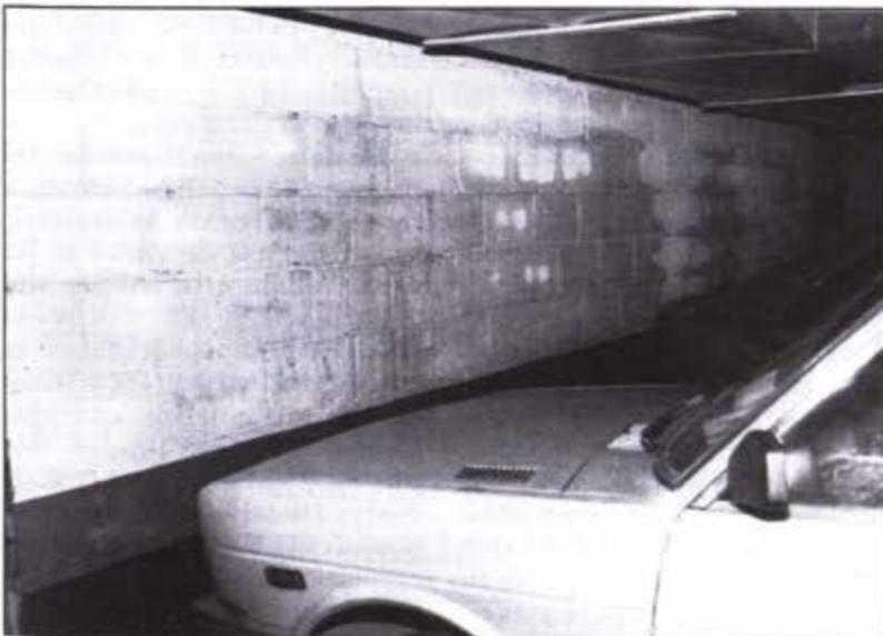
La humedad provocada por las filtraciones de agua es bien visible en las paredes, como muestra la fotografía.
