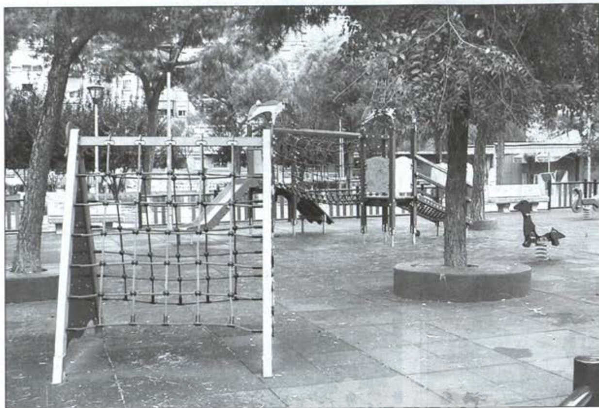
En la remodelación de la zona infantil, además de nuevos juegos, se ha puesto un piso de caucho
