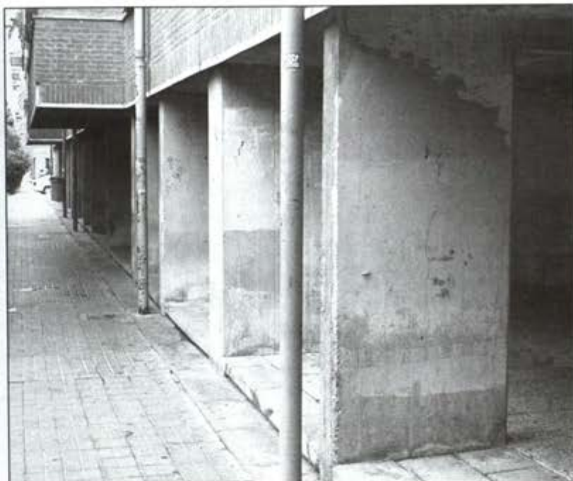
Aspecto de las columnas que no han sido pintadas
