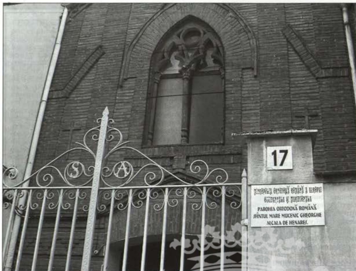
Fachada de la iglesia de las Adoratrices, situada en el Paseo de la Estación
