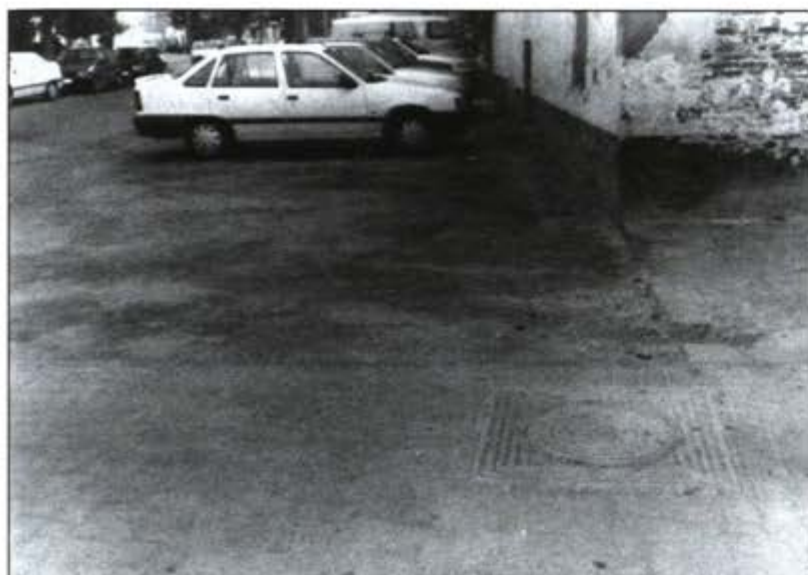
La acera está por construir en la Ronda de la Pescadería.
