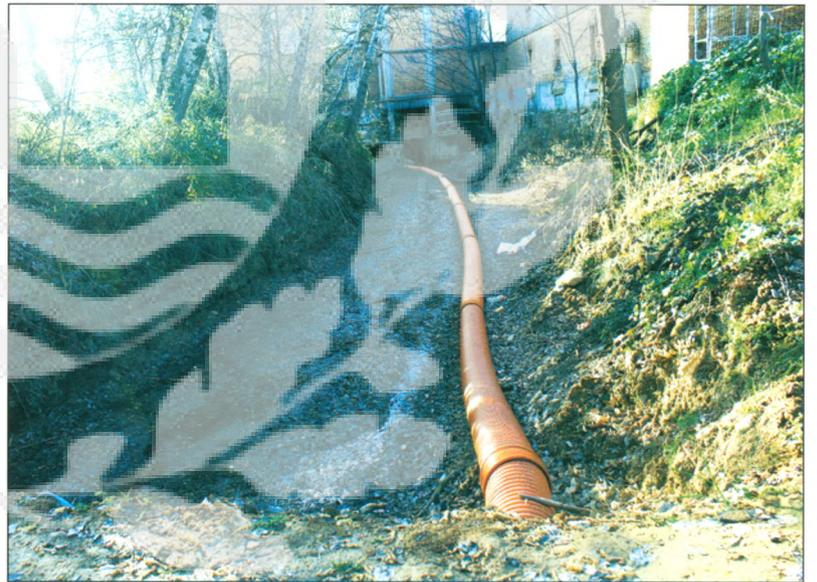
El caz ha sido cortado con este tapón de tierra, pero es atravesado por la tubería naranja hasta el otro lado del molino.
