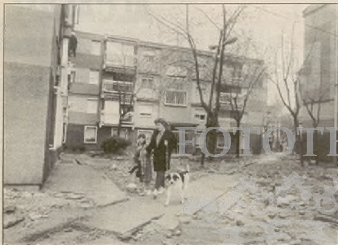
José Macías, concejal de Obras y Servicios, ve difícil desarrollar los 24 proyectos de arreglos de aceras y asfaltos
