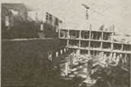
FOTO: Enero '96. Aspecto del sistema estructural en sus distintas plantas.
