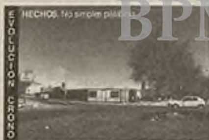
FOTO: Marzo '95. Derribo de las antiguas naves. Movimiento de tierras e instalación cédula de ventas.
