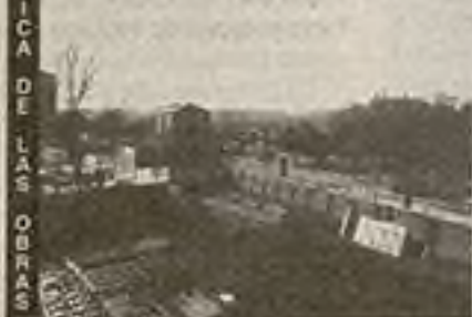
FOTO: Noviembre '95. Forjados en planta sótano.
