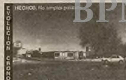
FOTO: Marzo '95. Derribo de las antiguas ruinas. Movimiento de tierras e instalación cimientos de vigas.
