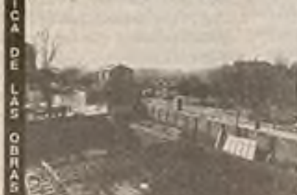
FOTO: Noviembre '95. Forjados en planta sótano.
