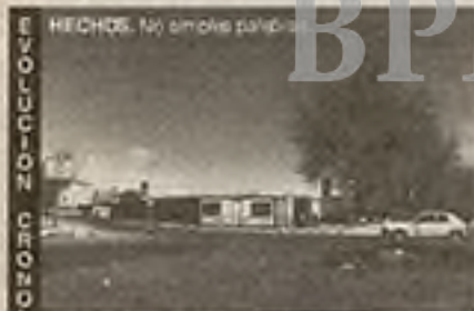
FOTO: Marzo '95. Derribo de las antiguas naves. Movimiento de tierras e instalación oficina de ventas.
