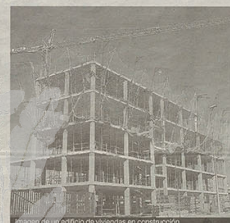
Imagen de un edificio de viviendas en construcción
