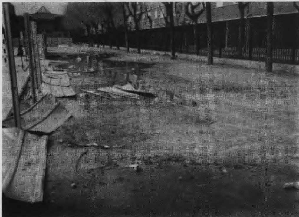
Zona deportiva del Colegio "Puerta de Madrid", con socavones y vallas derruidas
