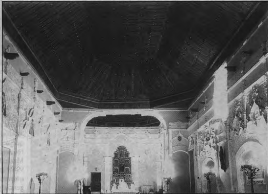
Artesonado y Yeserías de la Capilla del Colegio Mayor San Ildefonso
