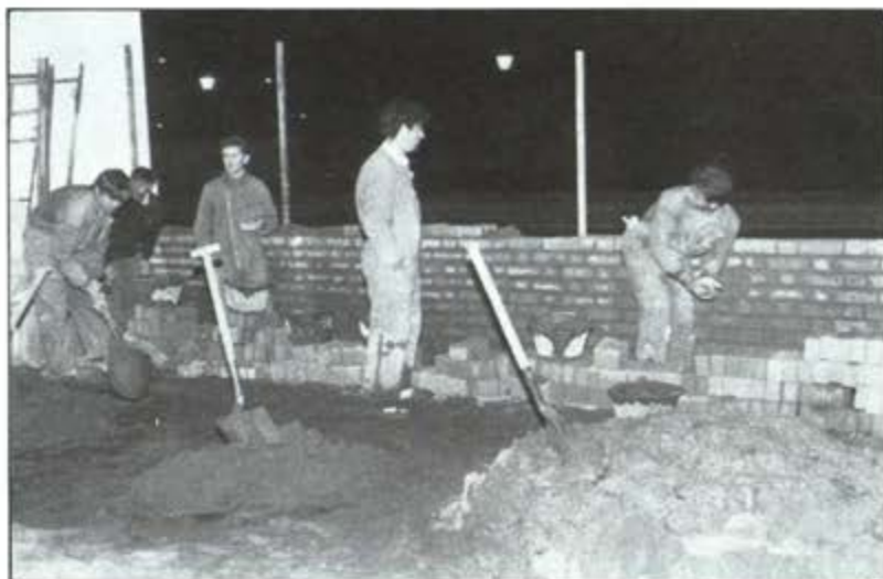
Fotografía tomada el miércoles 27 de febrero, a las once de la noche, mientras los albañiles cerraban el paso.
