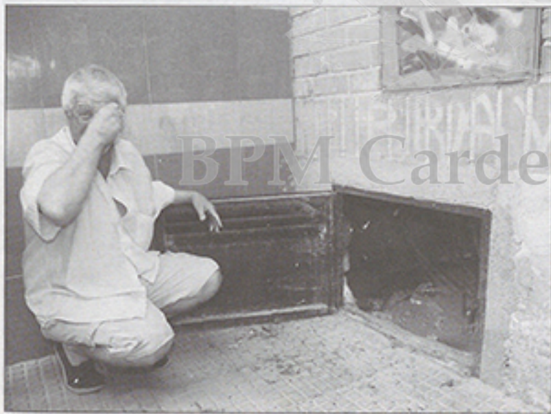
Instalación eléctrica del bloque, junto al alcantarillado.
