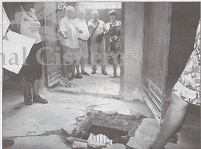
En los sótanos hay pozos negros. Al de la derecha le cae además agua de lluvia por esta rampa.
