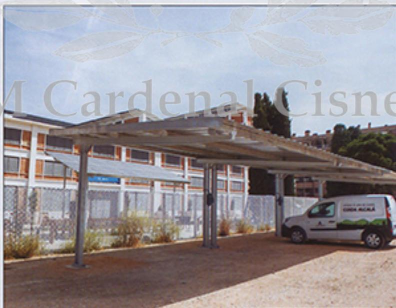
golas que la alimentan se han instalado 8 módulos fotovoltaicos con capacidad de generación de 2,5 Kw.
