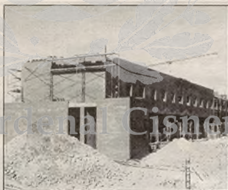
Aspecto actual de las obras
