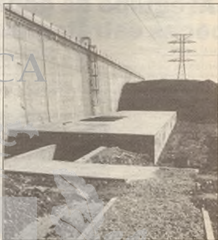
Nuevos depósitos de agua
