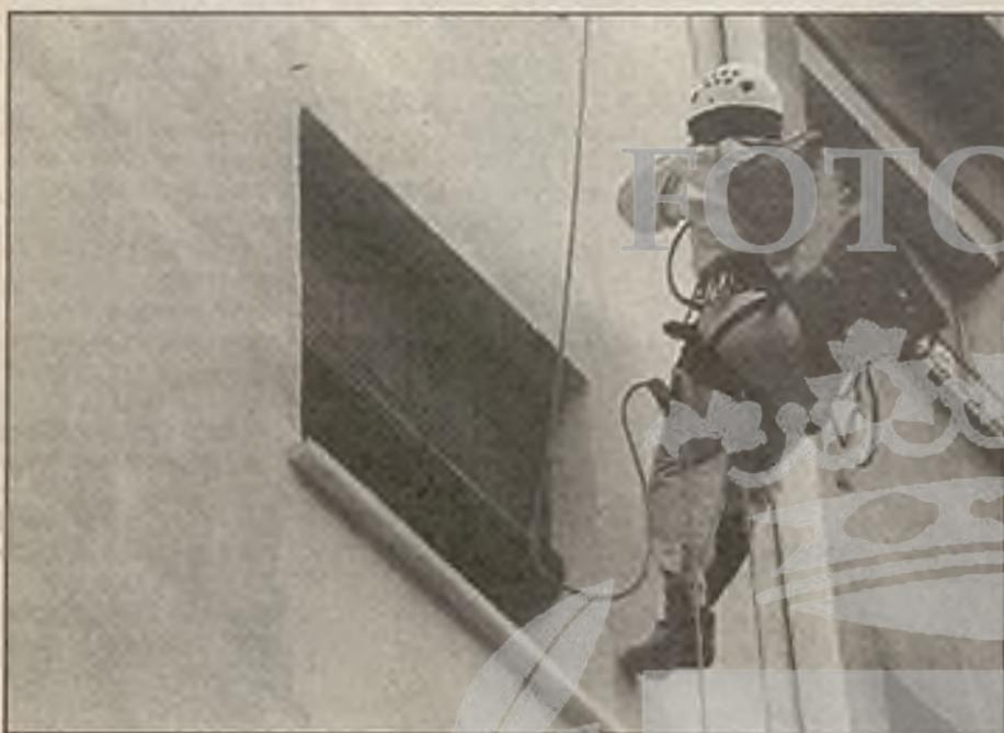
COMO SI SE TRATARA DE LA PARED VERTICAL DE UNA MONTAÑA, varios obreros de una empresa puntera en rehabilitación y restauración de edificios escalan la fachada de un bloque de pisos de Alcalá para arreglar desconchones y grietas sin utilizar andamios. Ataviados con cuerdas, arneses y mosquetones provocan la curiosidad de los viandantes, que se paran anonadados al verles manejar la paleta y el cemento colgados de una cuerda que, aunque fina, es capaz de soportar un peso de 3.000 kilos.
