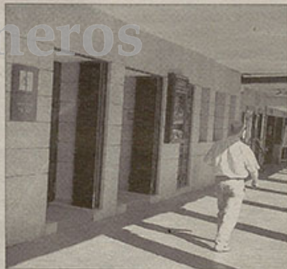
El edificio en la actualidad
