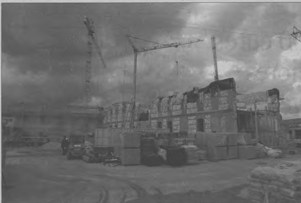
Aspecto actual de las obras en el futuro Parador.
