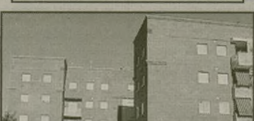
PISO ZONA ESTACIÓN. AZUQUECA DE HENARES. REF. 11925. Piso de 74 m., ext., 2 dorm., 3 a/e, salón, c/a y tendadero, 1 baño completo, s/gres, p/pino y v/a climatit, trastero y plaza de garaje.
