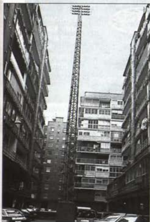
Torre de alta tensión en el centro de los bloques
