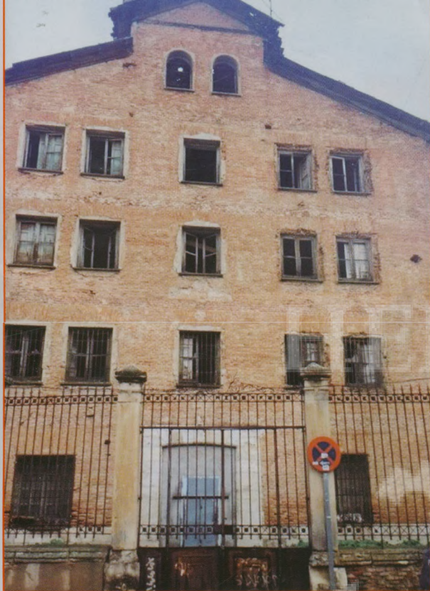
La Galera. Un volumen singular que fortalece la identidad de ese rincón del casco histórico, en lo que fuese la Puerta Nueva de las Tenerías y las primeras casitas que fueron dando lugar al Barrio Venecia en la década de los 50 del pasado siglo.
