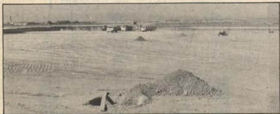
Las fotos recogen dos imágenes de los trabajos de movimiento de tierras que se llevan a cabo actualmente.
