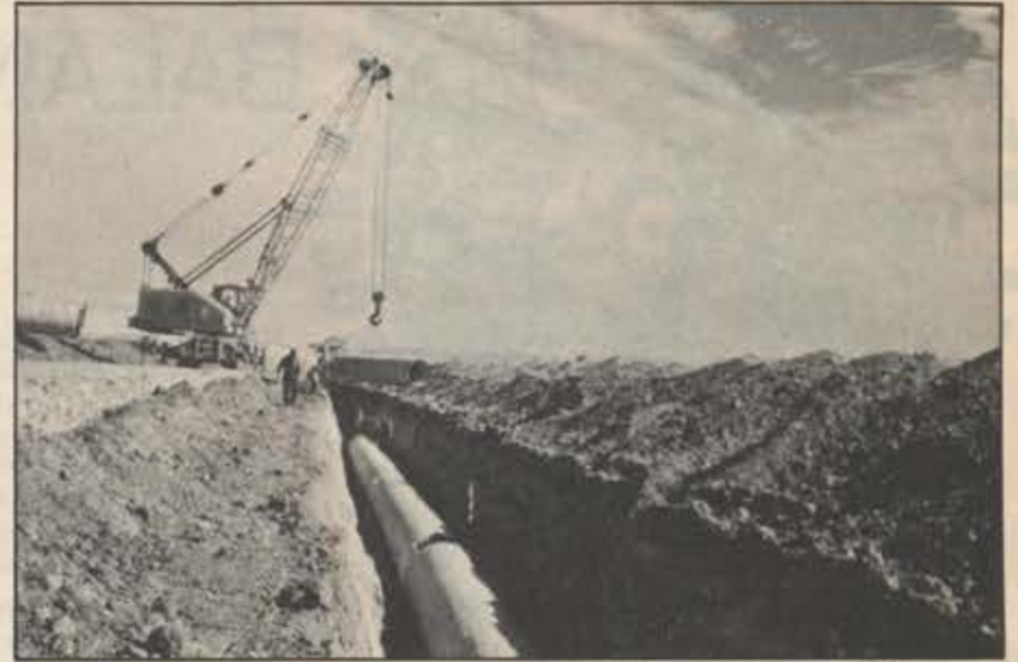
El desdoblamiento, cuya construcción ya se ha iniciado, es la solución definitiva para el abastecimiento de agua potable.
