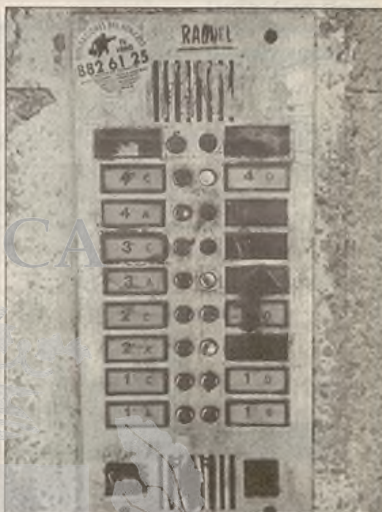
P.W. Muchos de los equipamientos básicos están deteriorados
