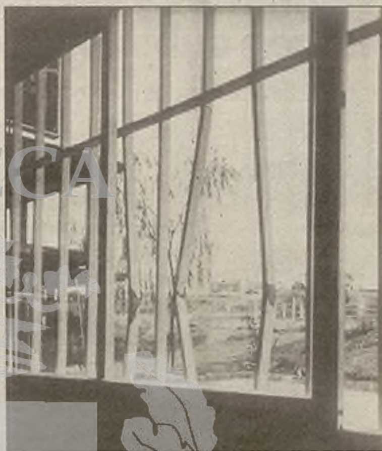
Estado en el que quedó una reja de un bar de Meco tras ser atracado
