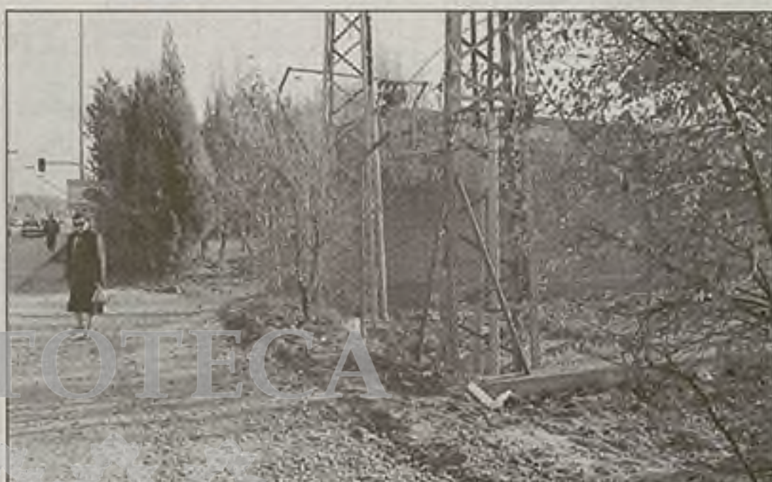
Los vecinos piden que se eliminen las torres de alta tensión del Camino del Juncal
