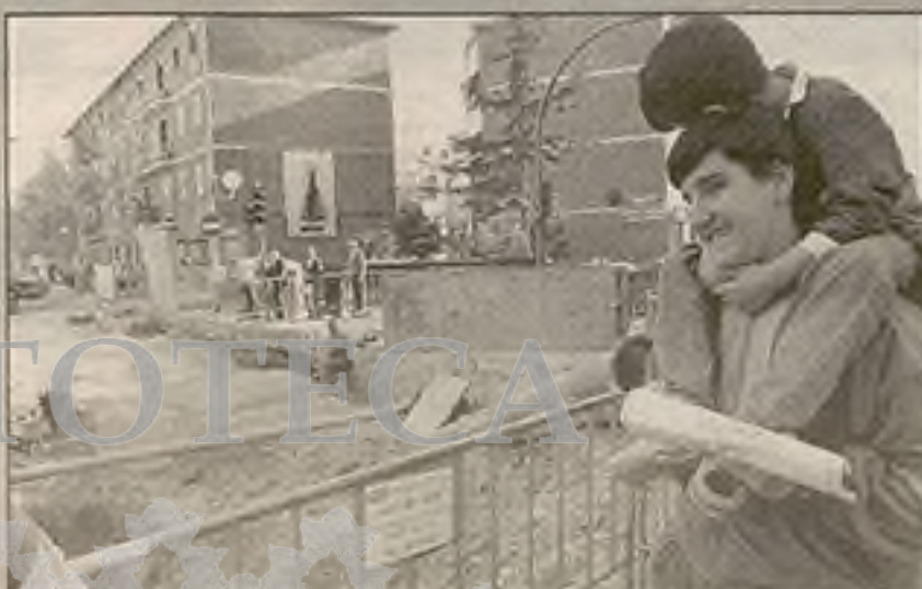
Las obras del Colector partieron en una de las principales calles complutenses, la del Marqués Alonso Martínez.
