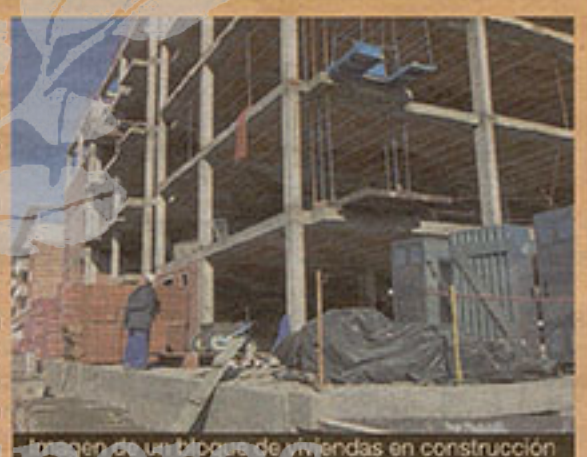
Imagen de un tipo de viviendas en construcción
