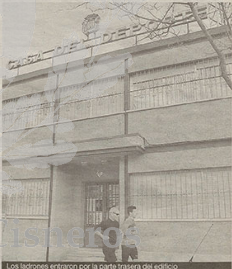
Los ladrones entraron por la parte trasera del edificio
