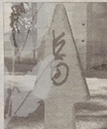
Una de las esculturas afectadas
