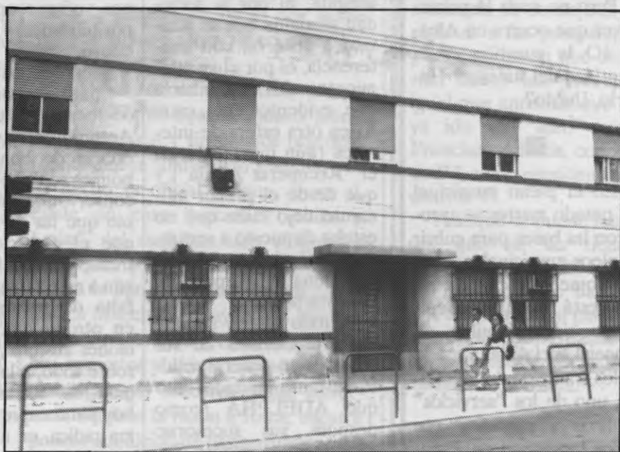
Edificio de la Farmacia Militar; su demolición, agrandaría la Plaza
