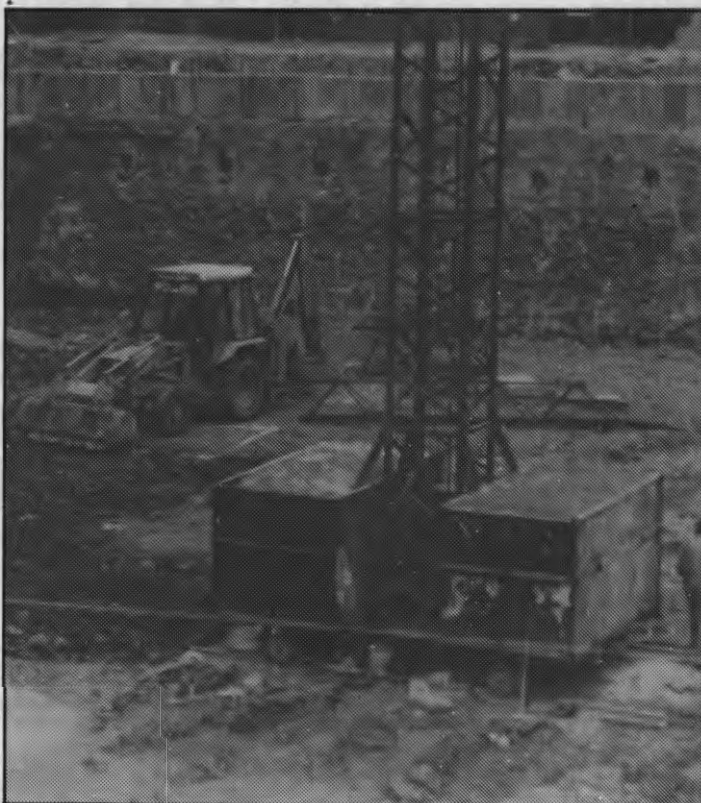
Obras del aparcamiento
