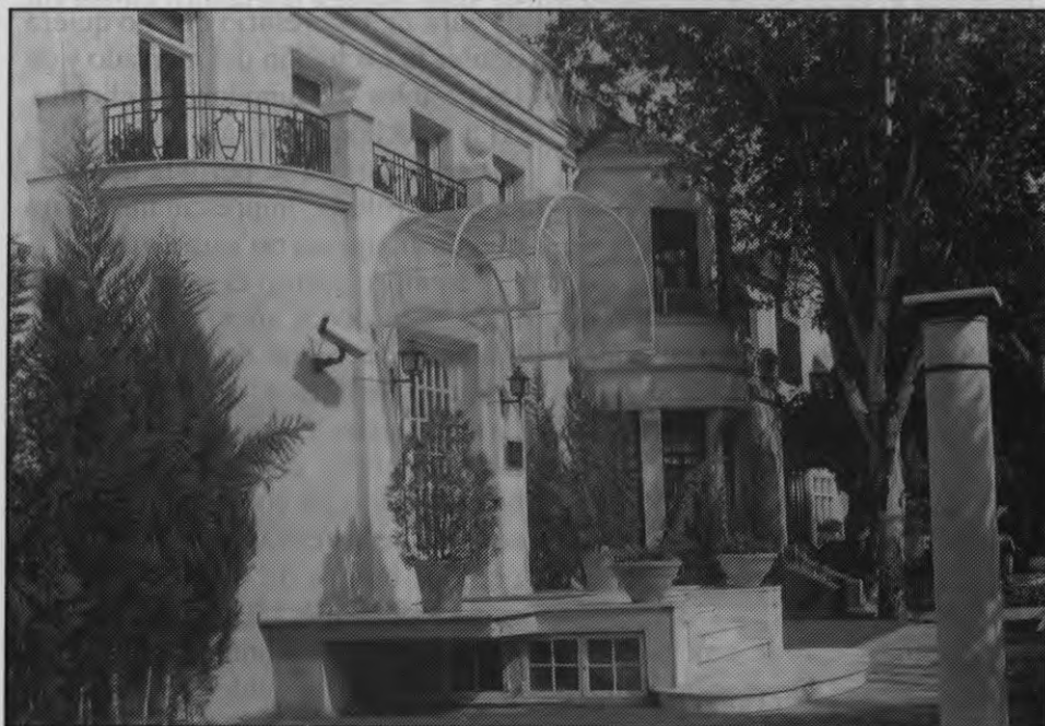
Vista parcial del Instituto de Empresa
