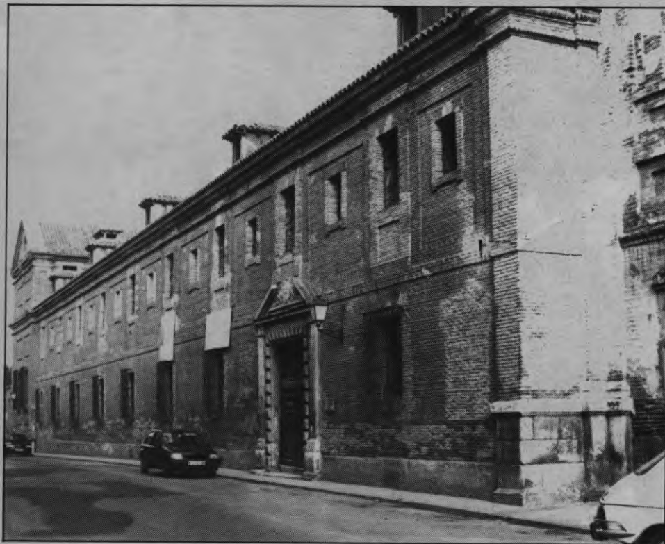
Convento de Caracholos, nueva sede de la futura biblioteca
