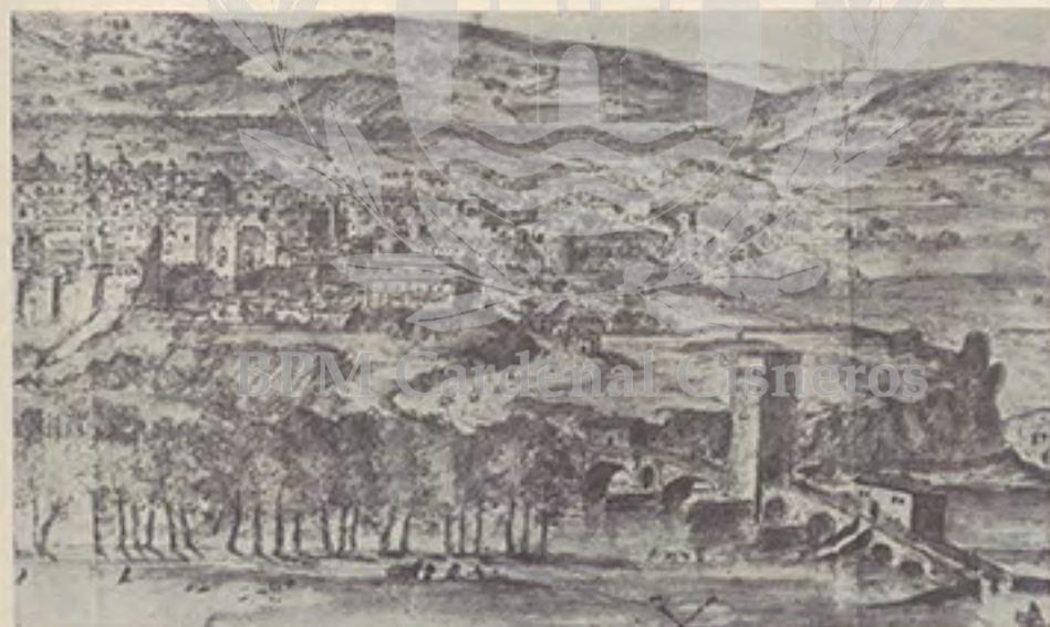
Antonio de las Viñas: Detalle del extremo septentrional con el Puente del Henares en primer término.
