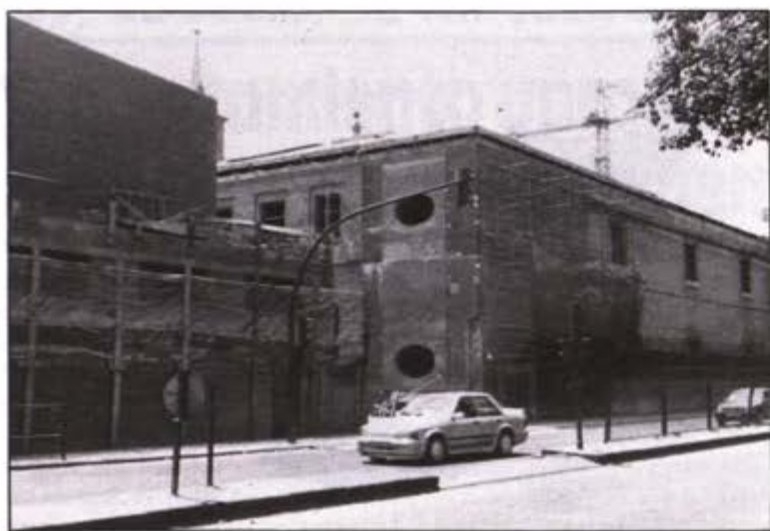
La parte nueva del edificio de Jesuitas tiene todo el aspecto de ser un mazacote.
