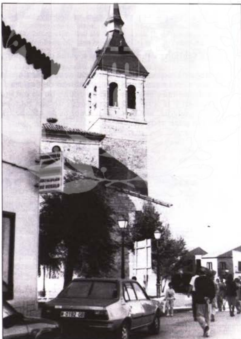
También se ha restaurado la torre de la Iglesia.
