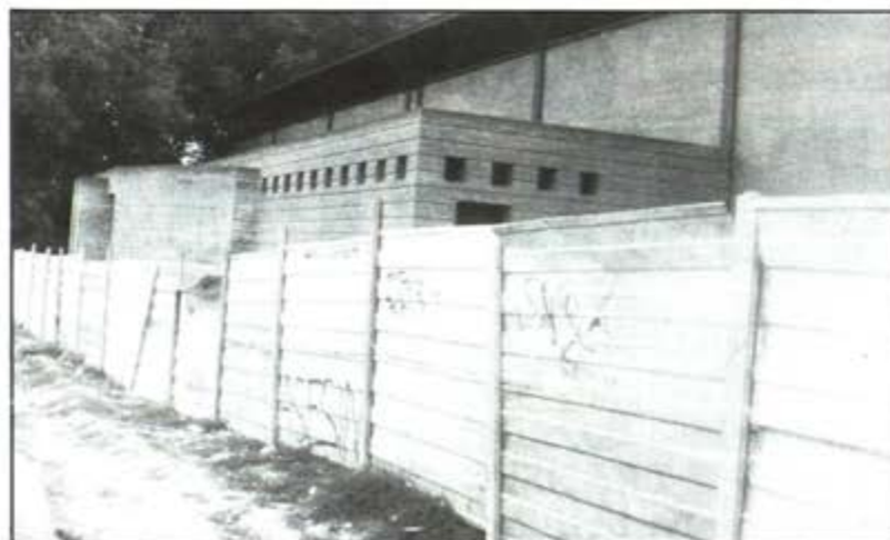
El pabellón polideportivo escolar permanece paralizado.
